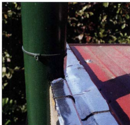
Bild 5: Abdichtung des Standrohrs zum Blechdach mit Bitumen-Dichtungsband
