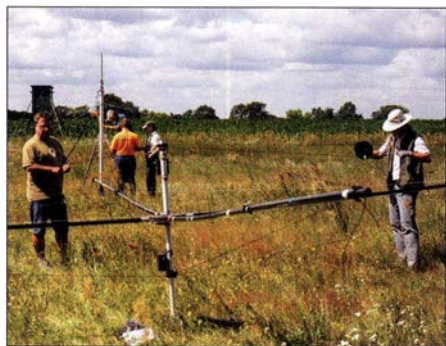
Aufbau eines WRTC-Spiderbeams für 40 m, 20 m, 15 m und 10 m
