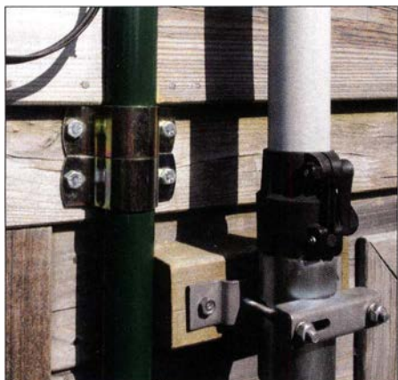
Bild 4: Montage des Standrohrs mit Rohrschellen und Maschinenschrauben
